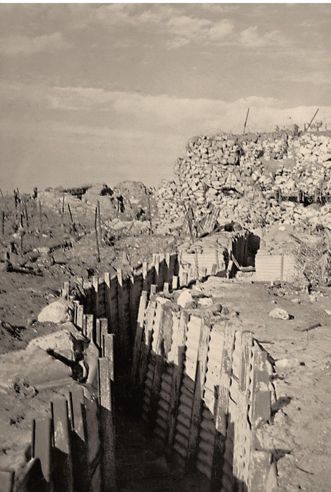
ВВЕРХУ Укрепления линии Бар-Лева
