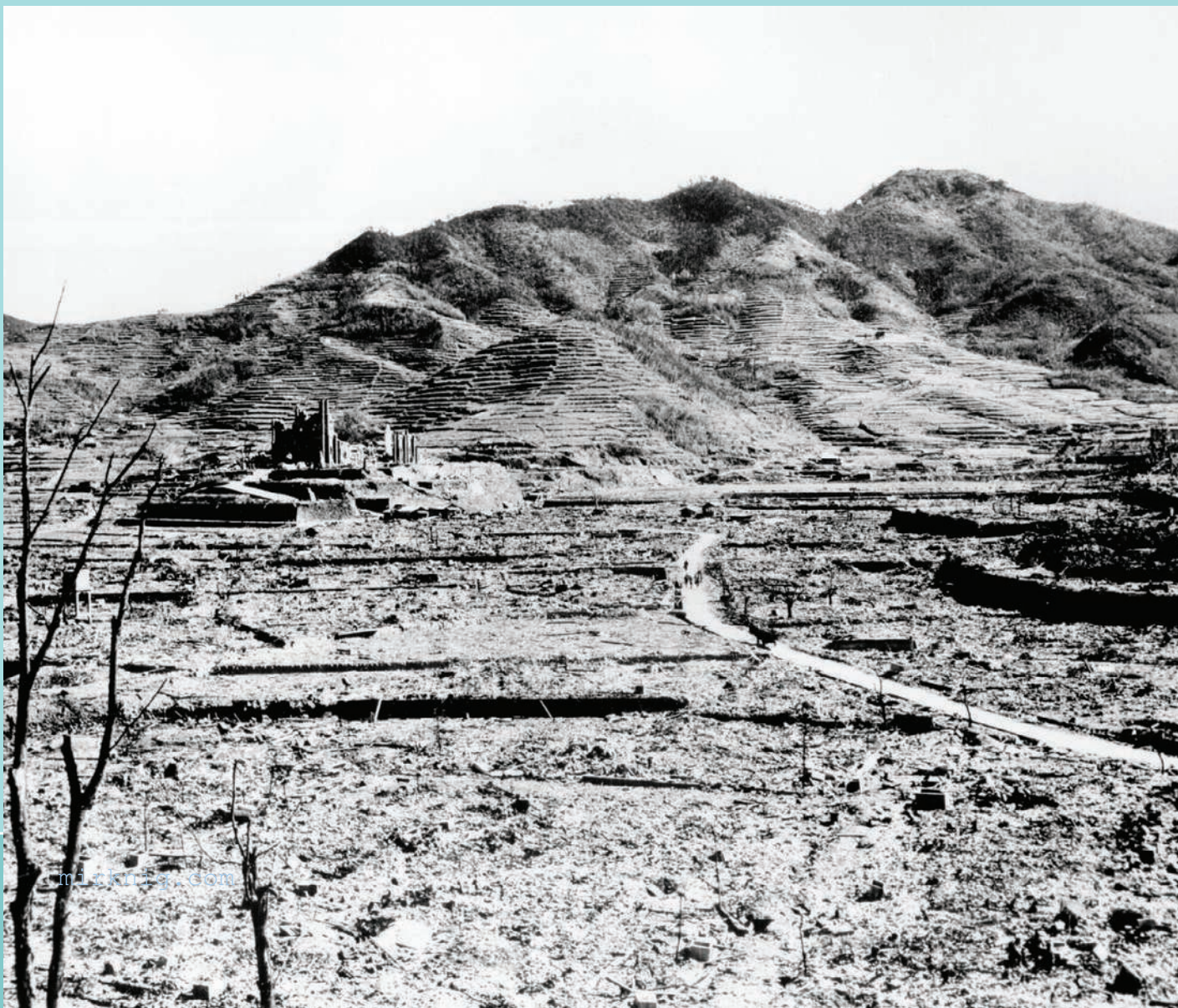
ВНИЗУ Разрушенный католический собор в Нагасаки
